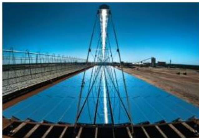
Figura 9: Planta Solar Fresnel na Índia. Fonte: HELIOCSP (2018)
