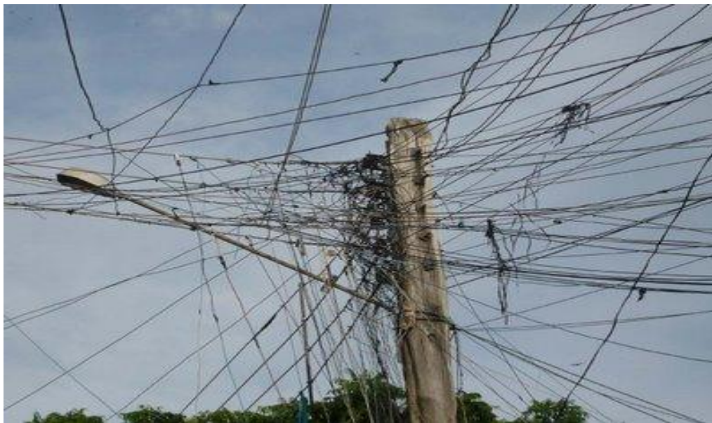
Figura 2 - Ligações clandestinas à rede de energia elétrica (“gato”)
