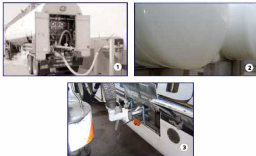
Figura 38: Abastecimento de gás liquefeito em Dallas (EUA): 1)Recebimento em caminhões; 2) Armazenamento em tanques criogênicos; 3) Abastecimento dos veículos, também em tanques criogênicos.
