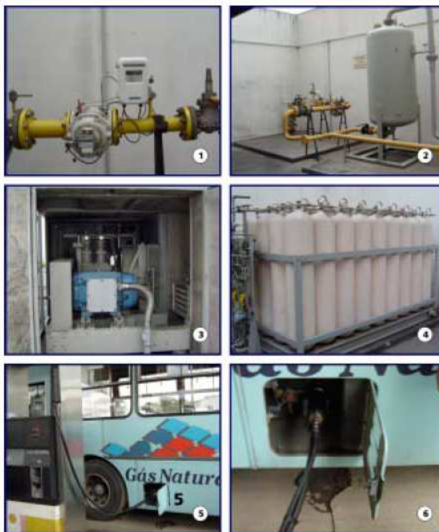
Figura 37: Seqüência de fotos; mostrando o esquema de funcionamento de uma estação de abastecimento rápido de gás comprimido:
