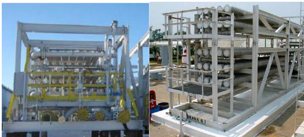
Figura 9: Skids com módulos de membranas do tipo UOP Separex™
