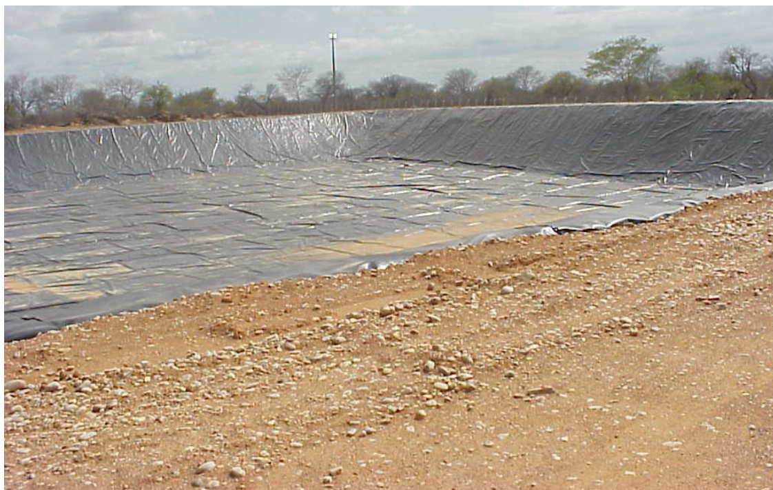
Figura 11. Obra de construção da estação central de disposição de resíduos sólidos no campo de Estreito.
