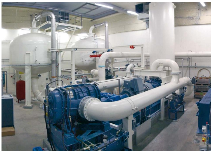
Figura 5-31 - Unidade VPSA para 1.300 Nm 3 /h de oxigênio.
