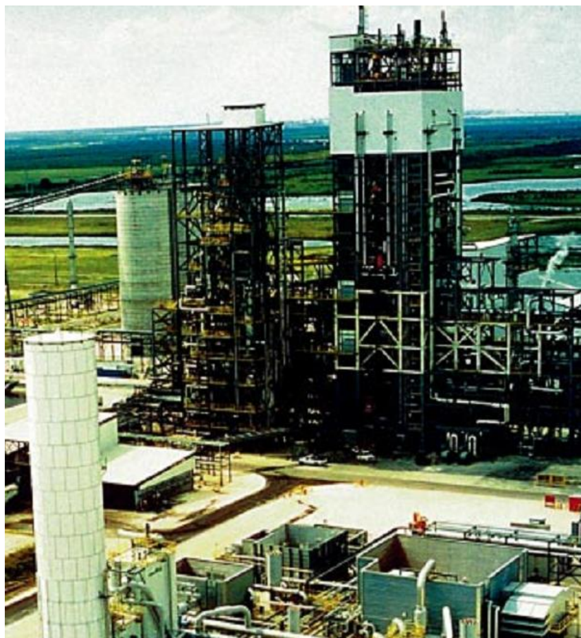
Figura 6-47 - Gasificador da Texaco em uma usina em Tampa. À esquerda pode ser visto o Syngas Cooler, e no primeiro plano a ASU.
