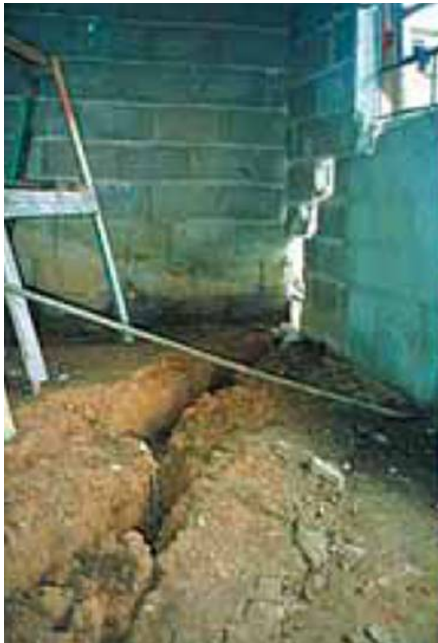
Figura 2.6 - Processo de rastejo, com evolução de trincas no solo e na moradia. Foto A: São Sebastião (SP); foto B: Tapiraí (SP). Fonte: Santos (2007).
