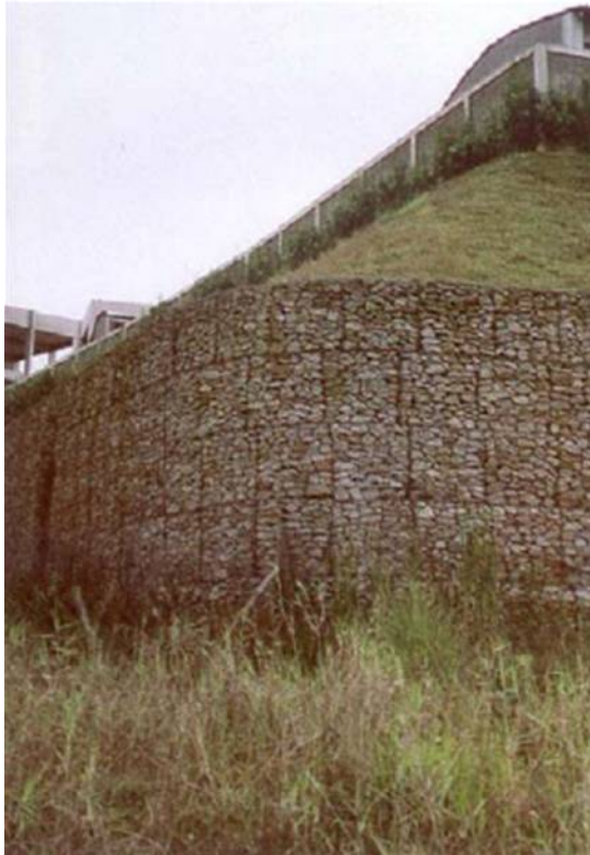
Figura 3.15 - Muro em Gabiões. Fonte: Bandeira (2003)
