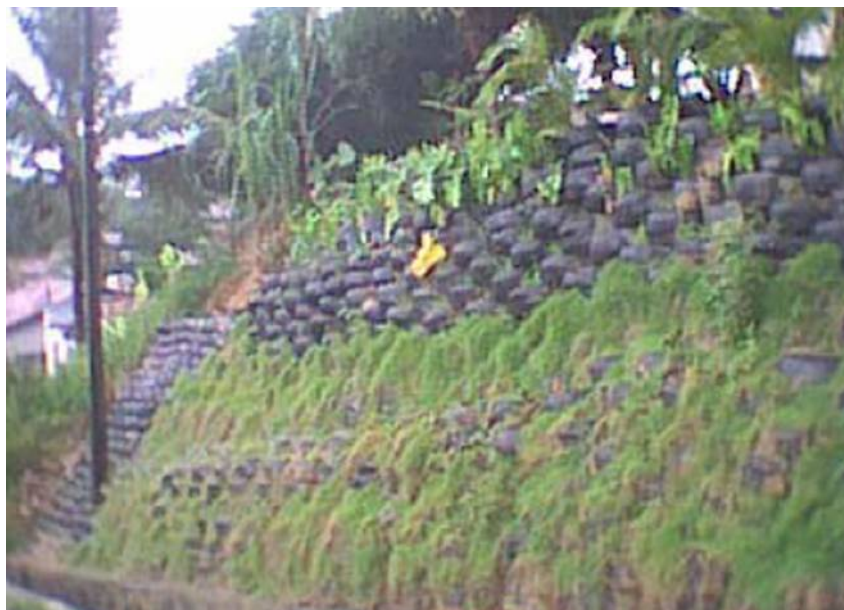
Figura 3.17 - Muro em Solo-pneus (Ibura – Recife/PE). Fonte: Bandeira (2003)
