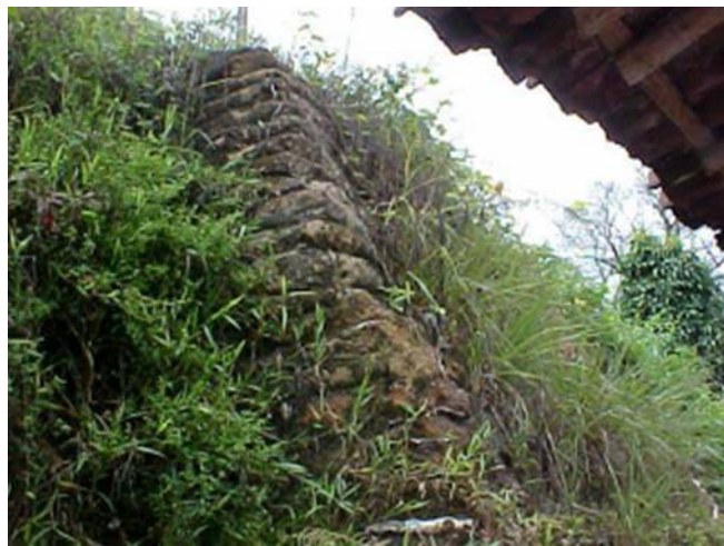
Figura 3.16 - Muro de Sacos de Solo-cimento (Camaragibe – PE). Fonte: Bandeira (2003)
