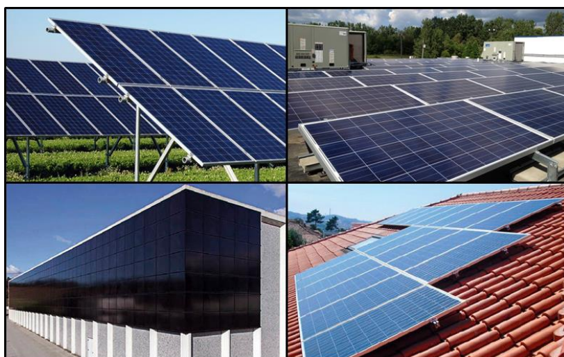
Figura 23. Imagens de arranjos de instalação. Em sentido horário a partir da foto superior esquerda: montagem livre; telhado plano; telhado inclinado; integrado à edificação.
