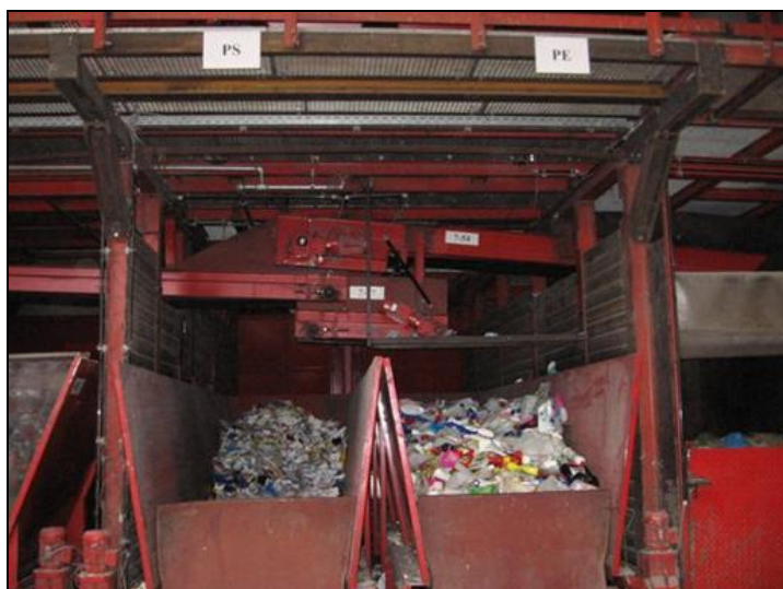
Figura 11 – Local de depósito de material separado em uma unidade de triagem na Alemanha
