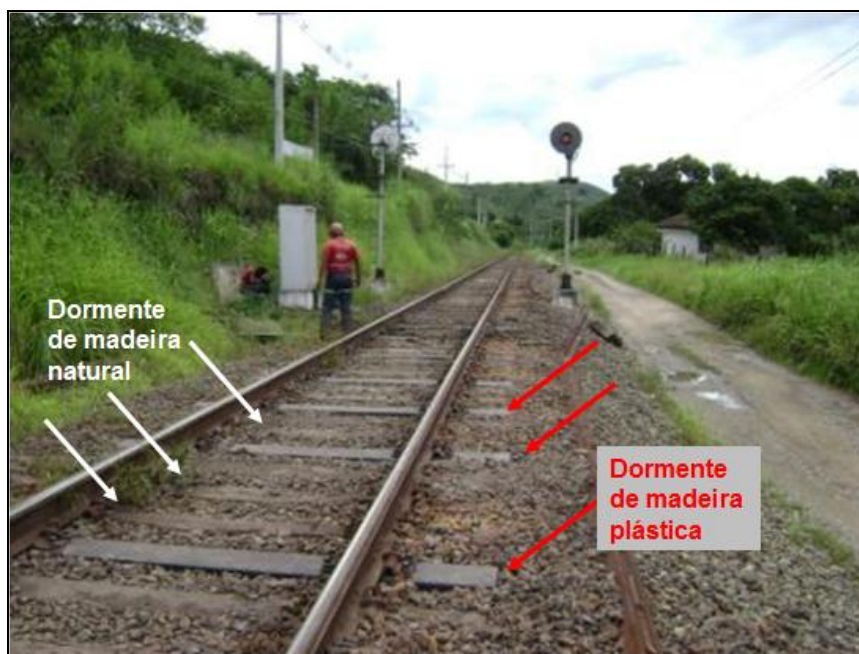
Figura 4 – Dormente de madeira plástica da Wisewood instalado na ferrovia da MRS Logística
