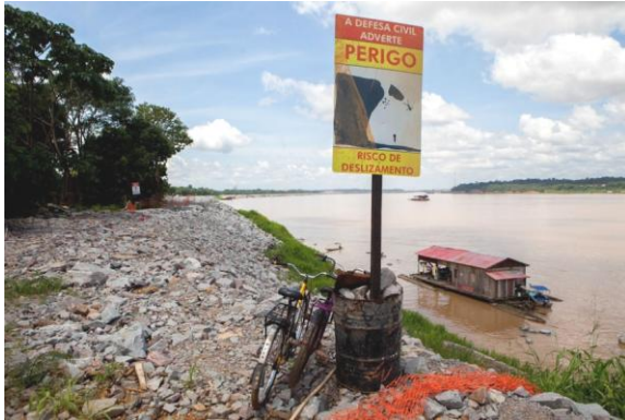
Figura 6.9: Pedras colocadas ao longo do rio para conter o deslizamento de terra proximidades da barragem do AHE Santo Antônio Fonte: Monteiro (2012)
