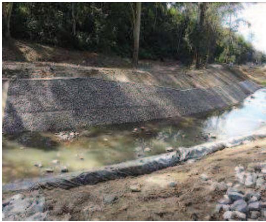
Foto 38 – Rio em obras de canalização, próximo à Estrada do Rio Pequeno, com a colocação de estrutura física para proteger a margem contra erosão fluvial (12/07/2013).
