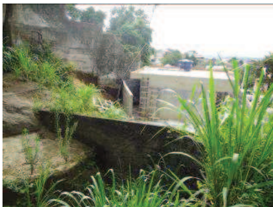
Foto 22 – Vista por trás de condomínio irregular aterrado com o próprio material de corte na Estrada do Curumaú, Taquara. (05/12/2011)
