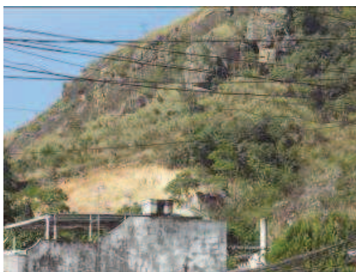
Foto 45 – Vista detalhada do corte na base da encosta formada por afloramento fraturado no final da Rua Sete Lagoas, gerando possivelmente maior instabilidade do material mineral e aumentando o risco de deslizamento (12/07/2013).
